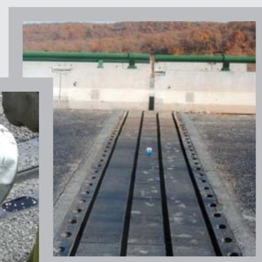
Para asegurar el correcto funcionamiento de las juntas se considera también necesario que los materiales que se emplean en su montaje cumplan unas determinadas características, ya que de ellos depende la resistencia de la base en la que se apoya la junta, el anclaje de la misma al tablero, y la defensa de los golpes del tráfico sobre la misma función que lleva a cabo la transición.
