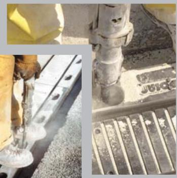
A continuación, se elaborará el mortero de resina de anclaje fluido y se verterá por colada, introduciendo los espárragos con su tuerca y arandela. Una vez curado el anclaje, se procederá a dar el par de apriete correspondiente.
