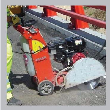
Una vez en obra, se localizarán las estructuras y se comprobará la junta a instalar, replanteando la misma y marcando a ambos lados del eje el ancho de corte, procediendo a cortar con máquina de disco de diamante a la profundidad adecuada.
